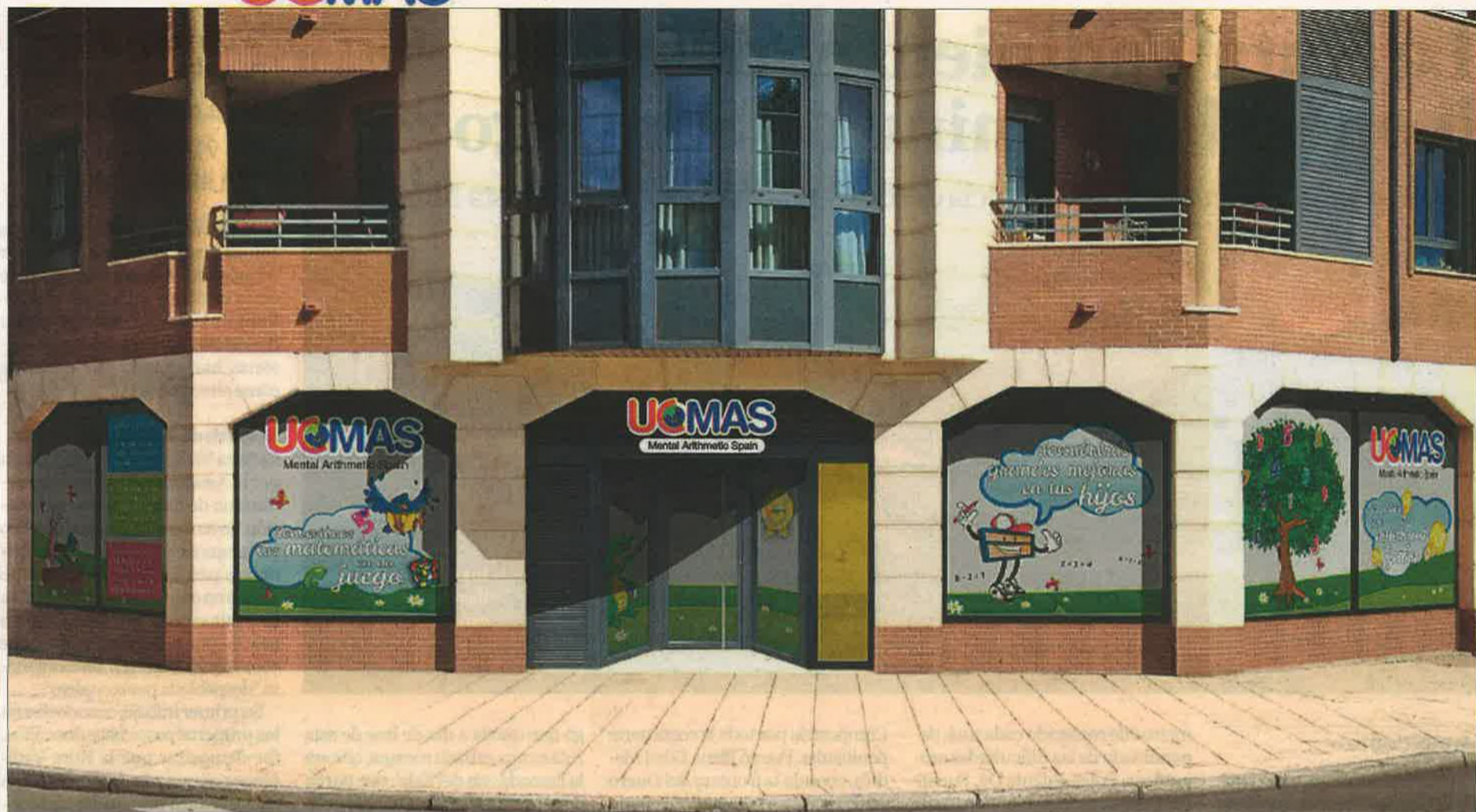
Fachada principal del Centro Educativo UCMAS que abrió recientemente sus puertas en el número 8 de la calle Velázquez, junto al parque de El Chantre. M. MARCOS
